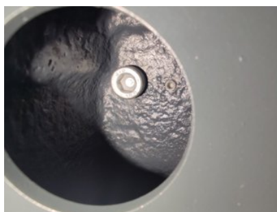
图 6-10: 箱体上定刀固定螺丝
