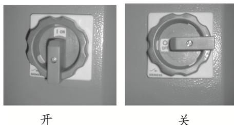
图 4-4: 主电源开关
