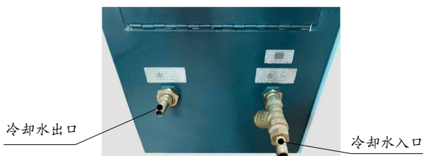
图 3-2: 冷却水管路连接
