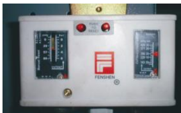
图 2-11: 高低压力控制器
