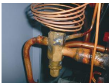
图 2-9: 热力膨胀阀
